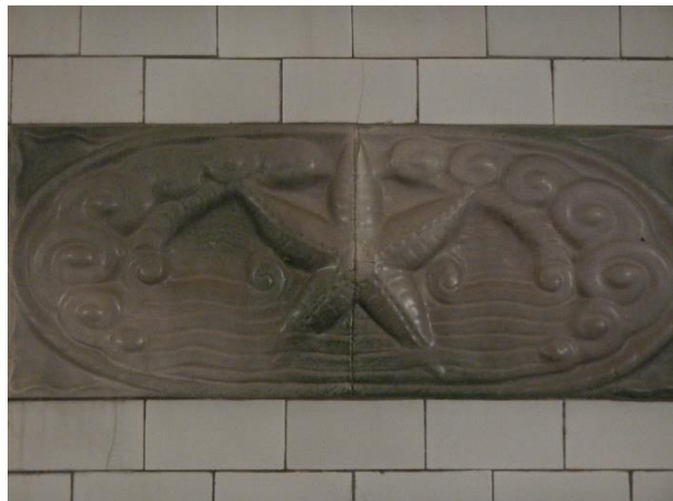
Wandfliesen im alten Elbtunnel
